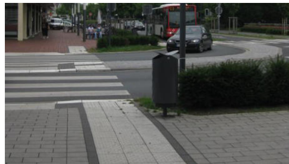
Abb. 36: Blindenleitsystem am Kreisverkehr am Bahnhof
