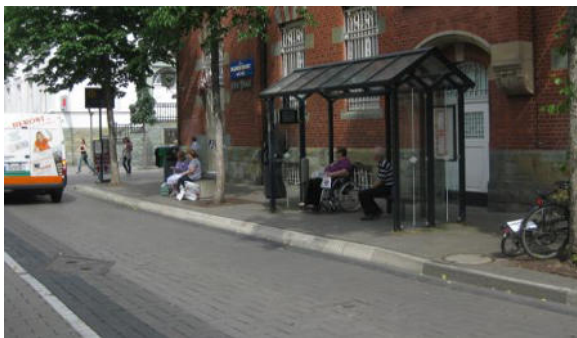
Abb. 39: Haltestelle „Alte Post“ mit Wetterschutz, Sitzgelegenheiten und Hochbord
