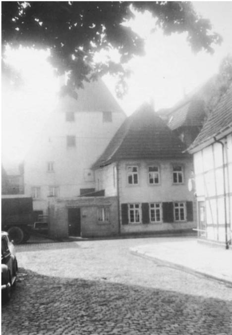
Nach Freilegung zahlreicher Bauspuren bestätigte sich die Vermutung, dass es sich bei dem Gebäude um einen der wenigen noch vorhandenen steinernen Saalbauten, ein sog. Steinwerk, aus dem 15. Jahrhundert handelte, dem zur Soeststraße vermutlich ein Fachwerkhaus vorgelagert war.
