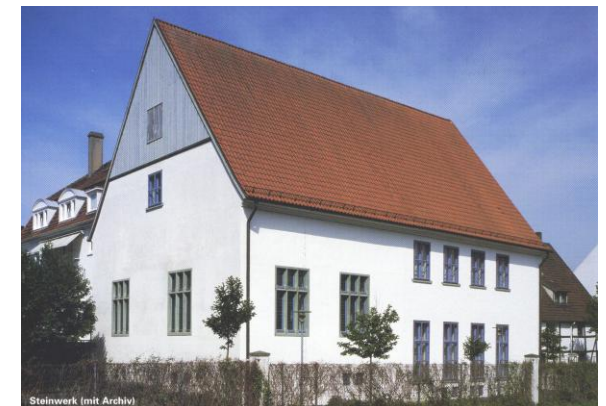
Steinwerk (mit Archiv)
